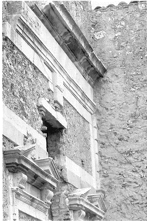
Roccavaldina. Palazzo Baronale: particolari della parete dello scalone.
