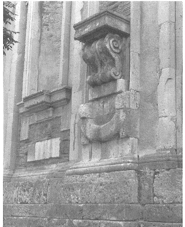
Chiesa di San Giovanni di Malta, la Tribuna: particolari della terminazione superiore del prospetto e del mensolone posto alla base della parasta.
